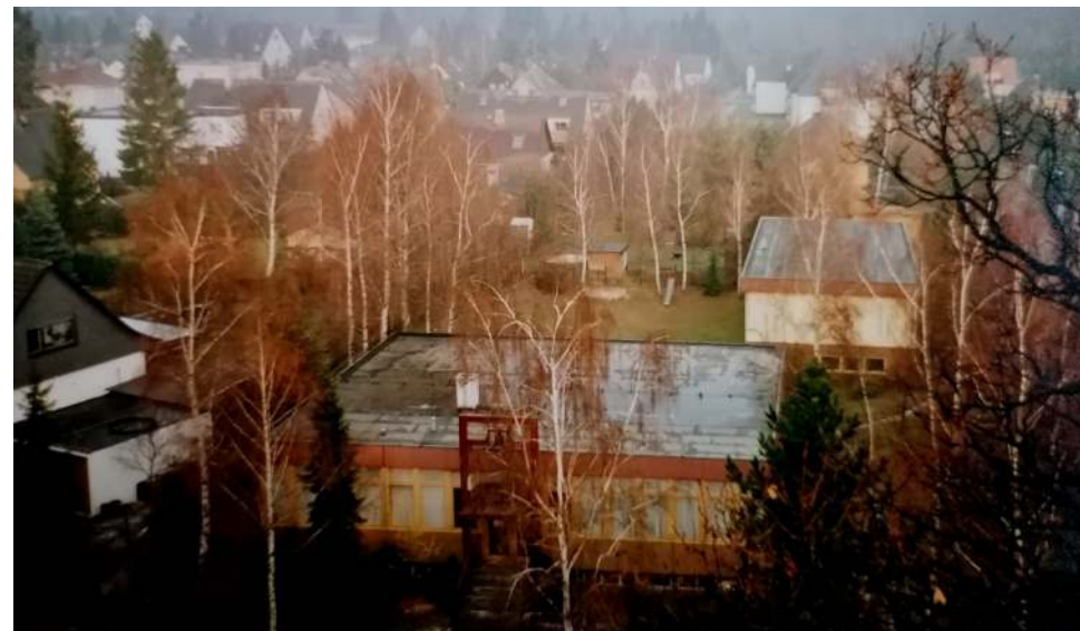
Die ehemaligen, als Provisorium errichteten Bauten der Radelandgemeinde
