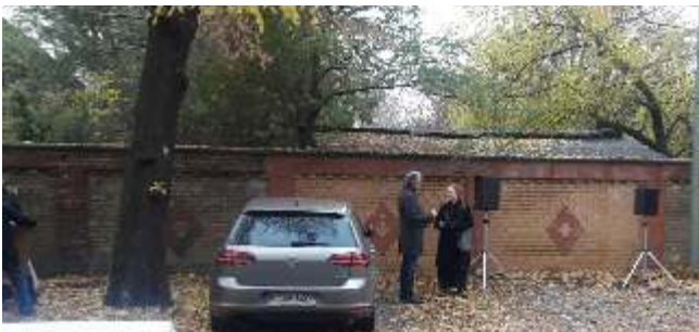
Das ehemalige Eingangsportal lässt sich an den helleren Steinen in der Mauer erkennen
